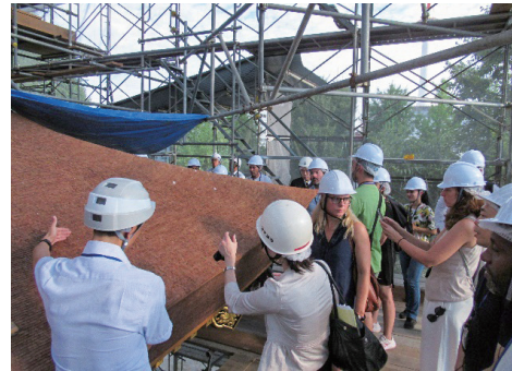
東本願寺鐘樓の修理工事についての説明風景
