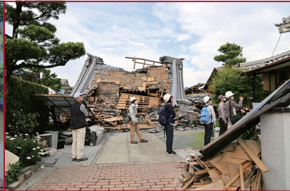
震災で倒壊した寺院の屋根（2016年、熊本・益城町）
