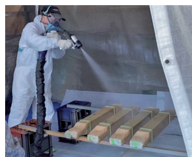
ポリウレア塗装施工状況
