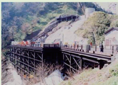
写真-13 連続繊維補強土工施工前
