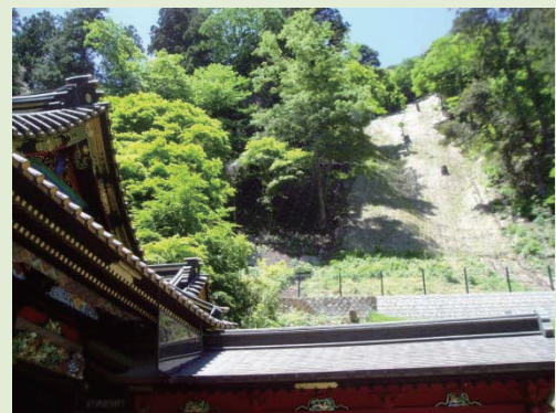
写真-5 p.30の事例で行われた養生マット(シート材)
