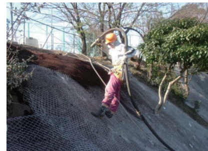
写真-12 森林表土混合植生基材の吹付
