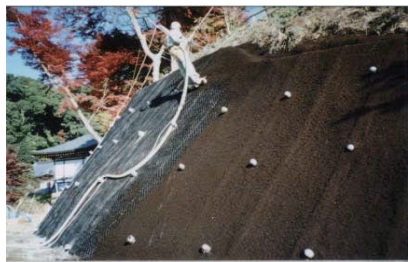
植生工の施工
