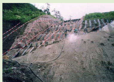
写真-14 連続繊維補強土工施工状況
