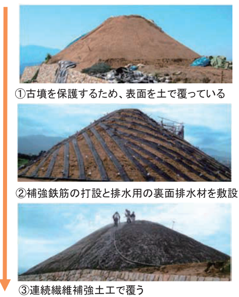
写真-3 連続繊維補強土による被覆
