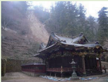
写真-17 対策斜面の全景
