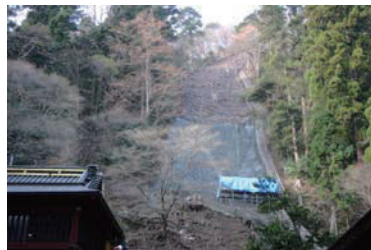
連続繊維補強土工施工状況
