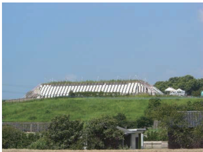
写真-10 EPS 軽量盛土による形成
