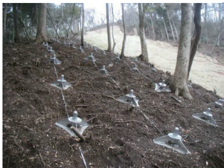
頭部ワイヤー連結型の鉄筋挿入工
