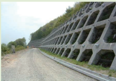
写真-8 のり砕によるのり面安定工
