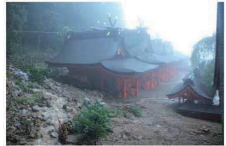
写真-1 熊野那智大社社殿被災状況
