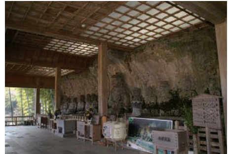
写真-5 覆堂により保護される古園磨崖仏群
