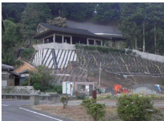
写真-7 対策工実施中
