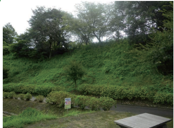
写真-9 自生種を主体とする緑に包まれた斜面
