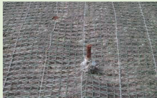
写真-4 植物の定着しやすさを目的としたネットの敷設
