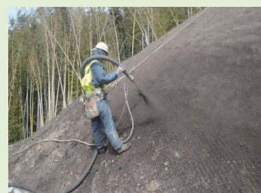
写真-15 森林表土混合緑化基材の吹付
