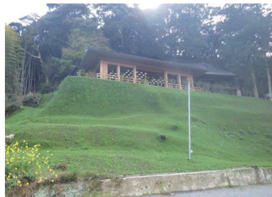
写真-8 復旧完了
