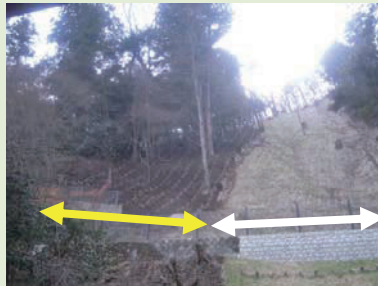
写真-18 対策斜面の全景(正面)
