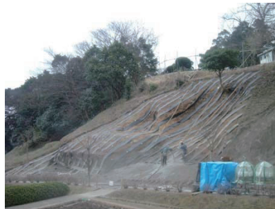
写真-11 連続繊維補強土工によるのり面保護
