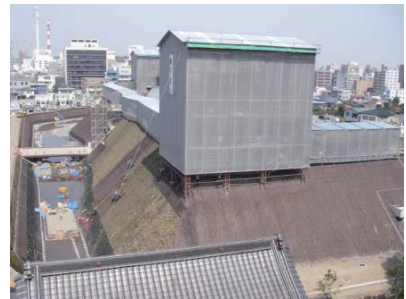
写真-6 植栽工実施
