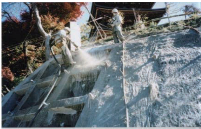
連続繊維補強土工による被覆
