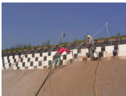
写真-11 連続繊維補強土による被覆保護
