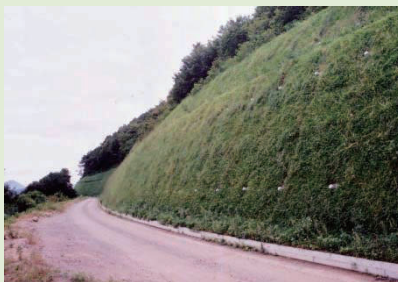
写真-9 砕内を建設発生土で被覆
