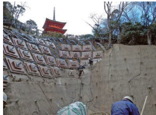
写真-4 グラウンドアンカー打設後(受圧板により被覆される)
