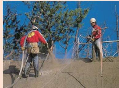
写真-3 連続繊維補強土築造状況
