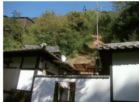
写真-4 2013年の崩壊(崩壊①)
