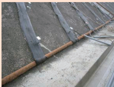
写真-5 裏面排水材と末端排水処理
