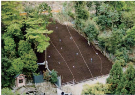
写真-2 連続繊維補強土工・植生基材吹付工完了直後
