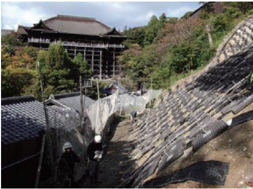
写真-1 鉄筋挿入工完了直後(受圧板がのり面に並ぶ)
