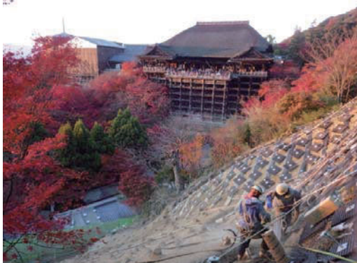
写真-2 受圧板を連続繊維補強土工で被覆
