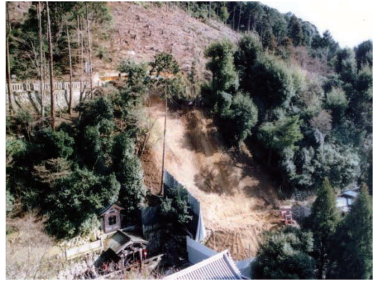
写真-1 崩壊直後
