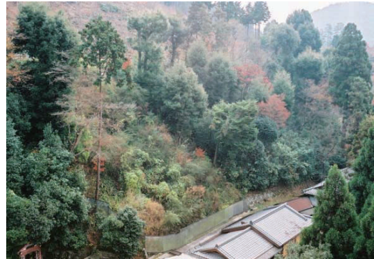
写真-3 植栽から7年経過した復旧斜面
