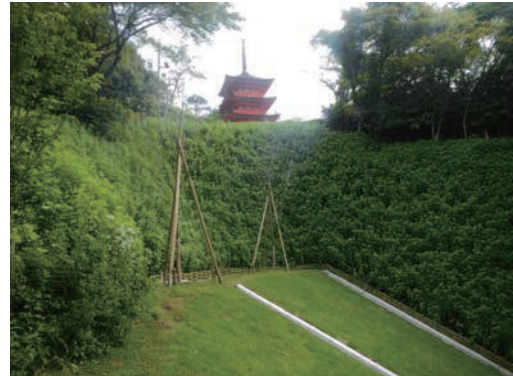
写真-5 復旧対策実施後
