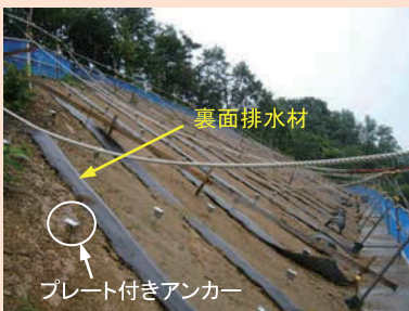
写真-4 背面地山の処理
