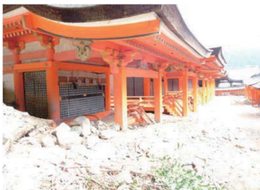
写真-1 土石に埋まる熊野那智大社社殿
