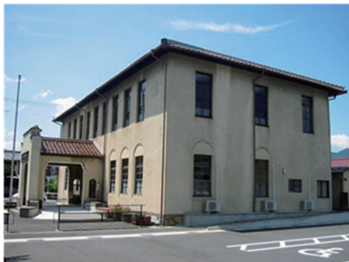
写真 3 旧加悦町役場庁舎の外観
