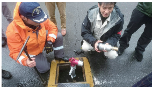
写真1 スタンドパイプと減圧バルブの設置訓練
