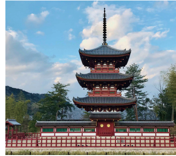
写真 5 伝統構法の技法による 三重塔
