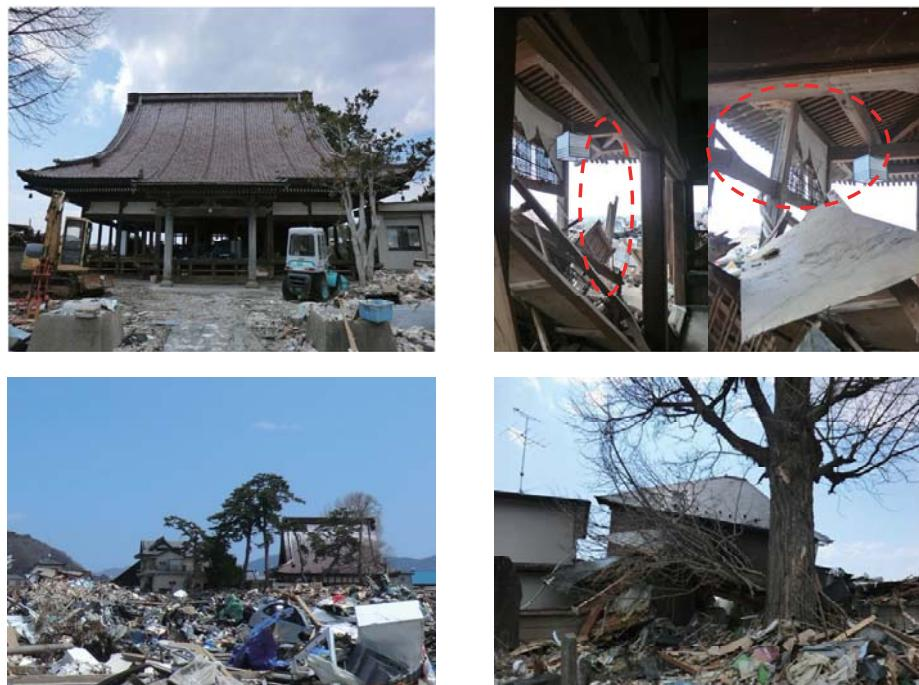
図 4-9 稽法寺本堂（左上）、被害を受けた柱および崩落した壁（右上）、稽法寺を取り囲む樹木（左下）、流れてきた住宅を受け止めた境内の大木（右下）
