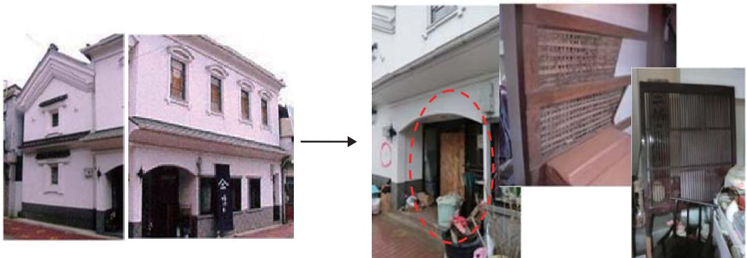
図 4-6 壁が一部剥落した三事堂ささ木土蔵、扉が被害を受けた三事堂ささ木店舗および住宅
