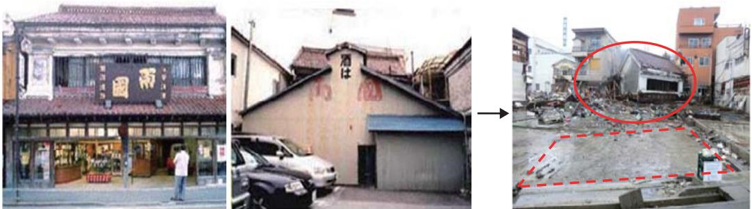
図 4-4 1階が倒壊し津波によって流された角星店舗の2階部分（点線台形は元々角星店舗が立地していた場所）
