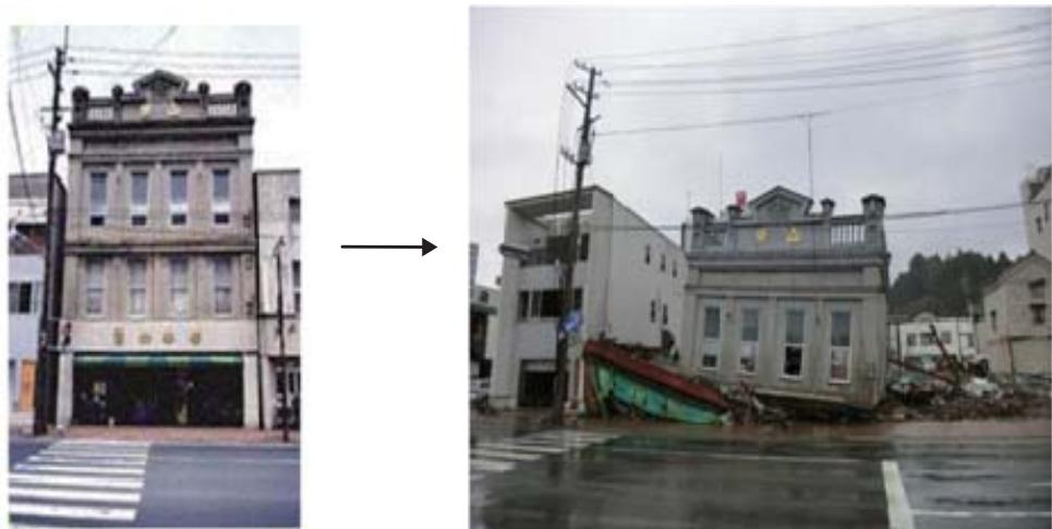
図4-3 1・2階が倒壊した男山本店（以下の図においても文化財の被害前の図はいずれも文化庁<sup>13)</sup>より）
