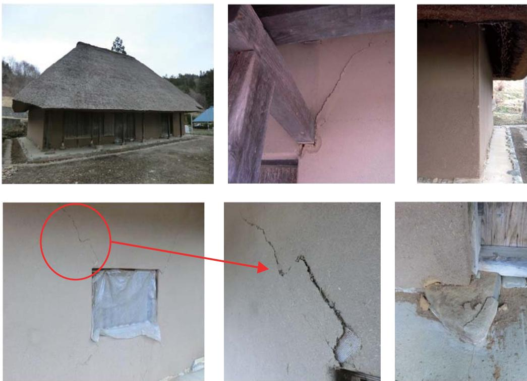
図4-14 伊藤家全体像（左上）と破損箇所（上中央：戸部角亀裂、上右：壁亀裂、
