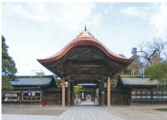
写真1 対象建造物(補強後)
