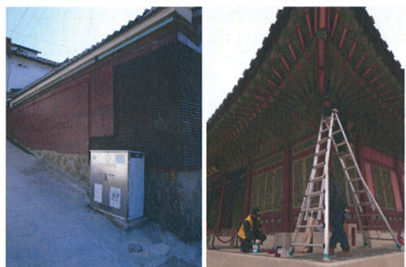
写真11 北村地区の消火栓設備(左)
