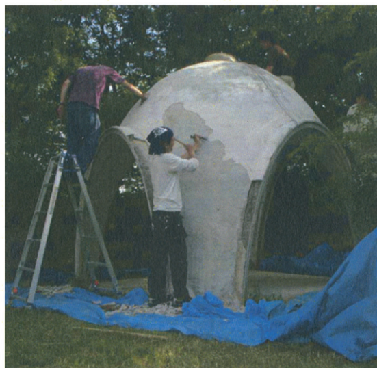
写真 1 仕上げはつり状況
