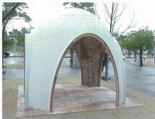
写真2: 完成した左官シェル
