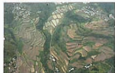
六甲山の積苗工
