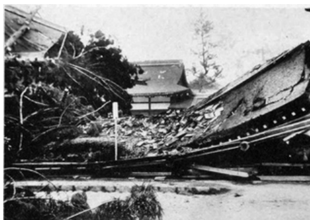
写真1 下鴨神社における倒木による建物の破壊
