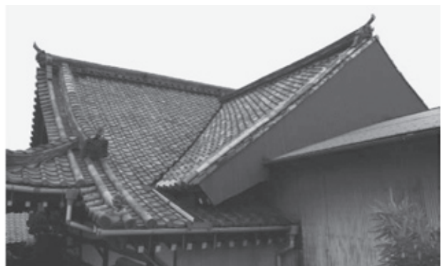
図10 屋根全景(北西より) 北側は古い瓦が用いられ、後堂は鉄板葺きとなっている。
