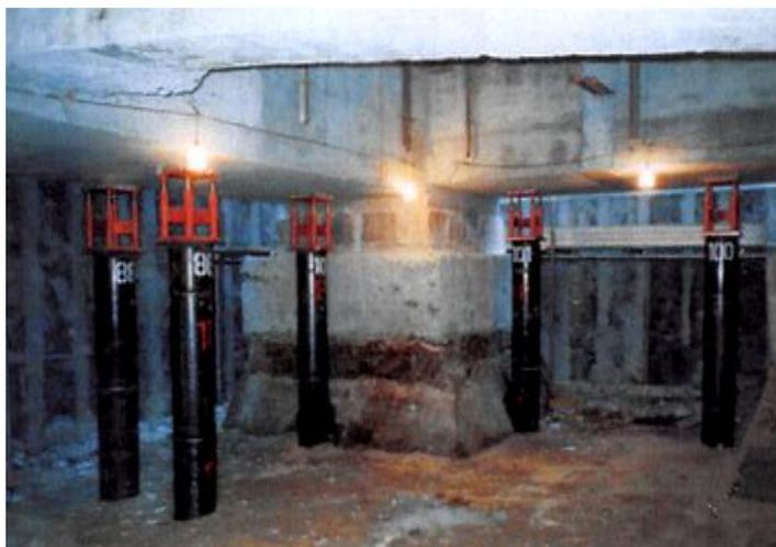
仮受け鋼管杭工法施工途中
