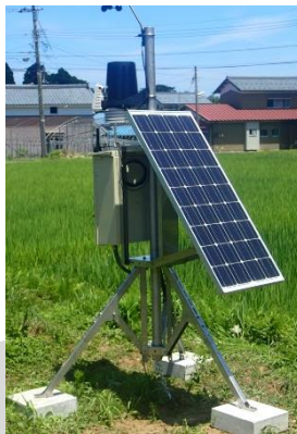
雨量データ (雨量計の設置/気象庁アメダス)
