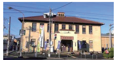
2018年度耐震改修予定の 与謝野市旧加悦町役場庁舎
