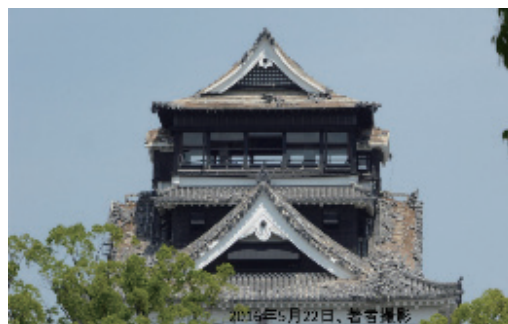
写真 1 熊本城天守閣の被災様子 （崔明姫撮影 2016 年 5 月）
