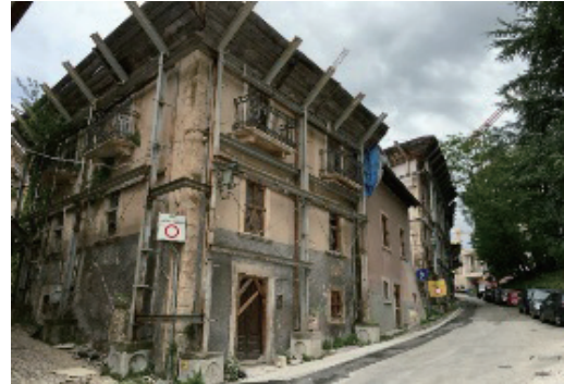
写真2 ラクイラ地震2009の復興状況筋交いにより倒壊防止のままの放置 (鐘ヶ江秀彦撮影 2016年)
