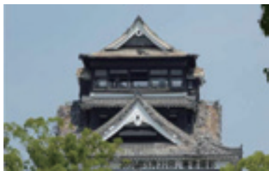
熊本城天守閣の被災様子
