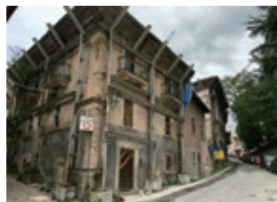
ラクイラ地震2009の復興状況 筋交い、フレームにより倒壊防止のままの放置状況
