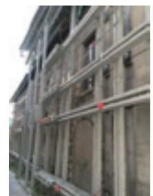
ラクイラ地震2009の復興状況 筋交い、フレームにより倒壊防止のままの放置状況
