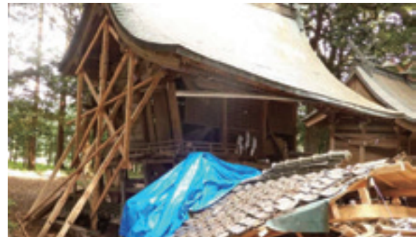
本殿は、大きく傾斜。現在、倒壊防止対策を施している。
