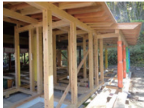
農家型住宅を耐震補強・改装して一般的な住宅に改修した
