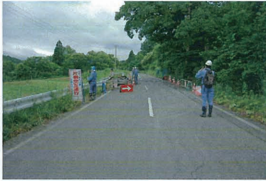
写真1 衣川区餅転の道路に現れた地変
