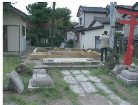
写真4:倒壊したお堂は撤去され土台が残る
