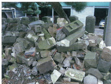
写真3:倒壊した寺院の墓石など
