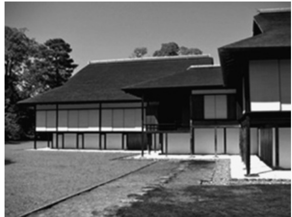
写真3 高床構造を採用する新御殿。
