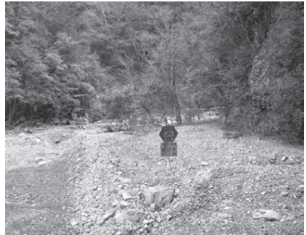
第7図 2004年21号台風豪雨で三重県宮川村の谷筋から土砂流出。県道脇の道路標識は2m余り埋積したにもかかわらず、無傷。土石流ではなく土砂流であったことを示す。
