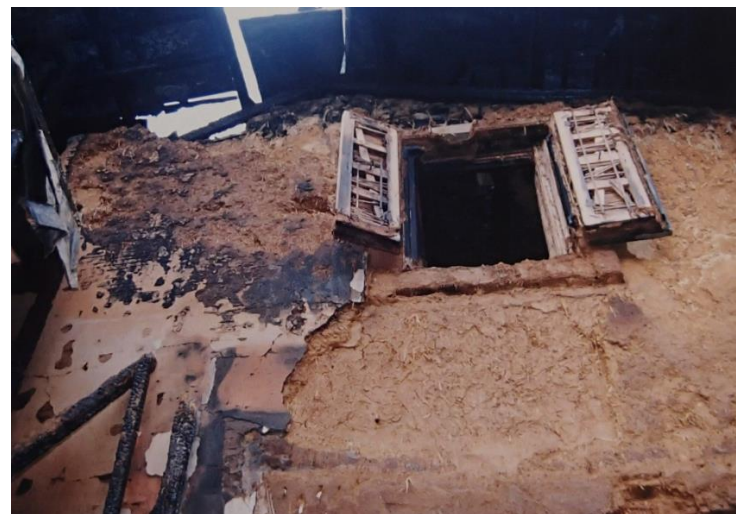
写真2 平成8年火災時の土蔵被害※2)
