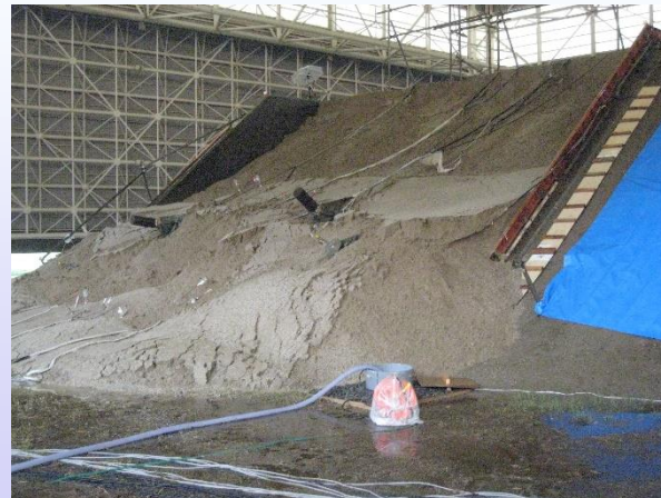
崩壊後の様子
