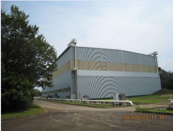
大型降雨実験施設 幅49mx長さ76mx高さ21m
