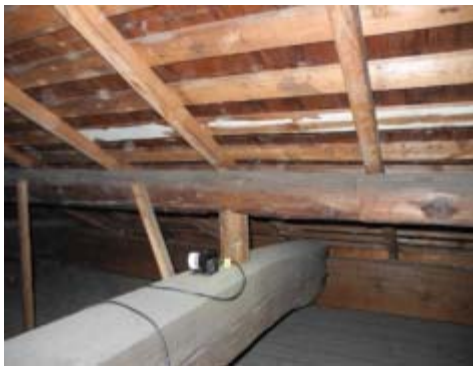
微動計 (VSE15 × 18 台)
