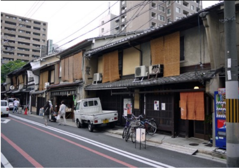
町家を改修した料亭 (上京区)
