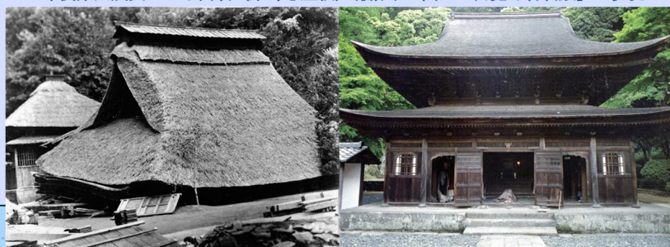
1923年関東大震災による倒壊(茅葺き屋根)鎌倉市 国宝「円覚寺舍利殿」の現況
